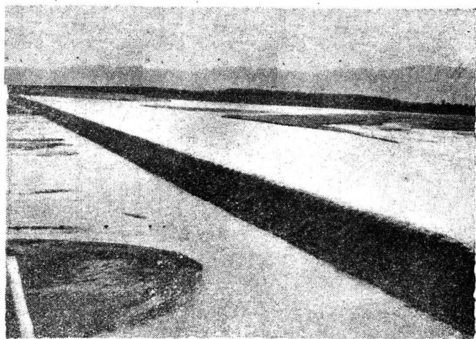
陝西渭惠渠攔河滾水大壩
