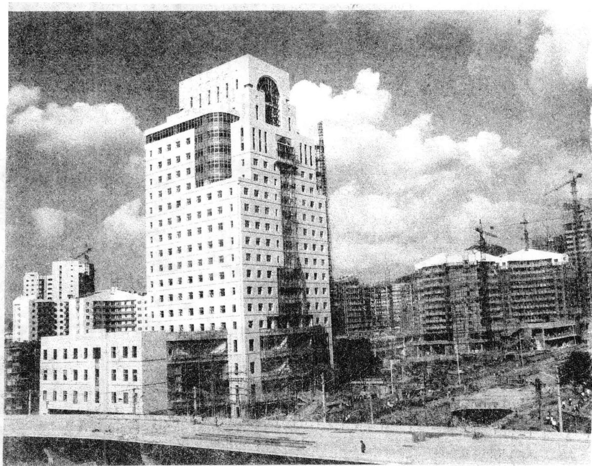
建设中的永丰改造区
