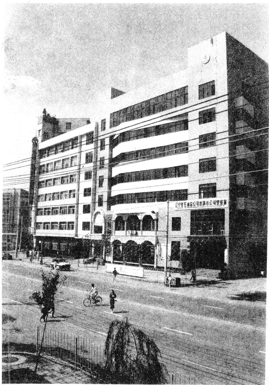
省石油总公司本溪营业处新楼
