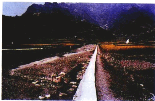
► 乡镇河堤建设
