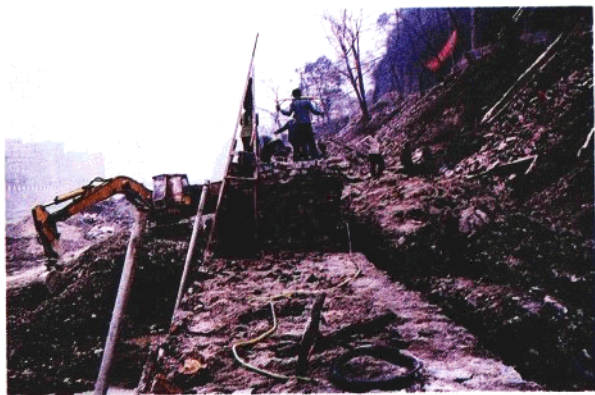
◀ 修建城区河堤 保护市民家园
