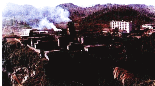
◀ 麻田坝水泥厂
