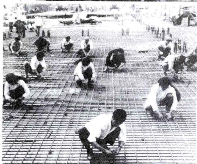
建设者们顶着烈日在编织凉水塔地基钢筋
