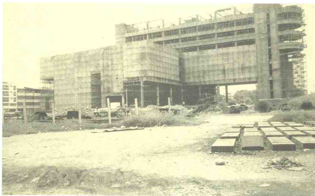
■一期建築施工情形
