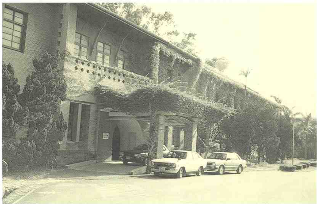
■座落國立中興大學理工學院之本館籌備處外觀
