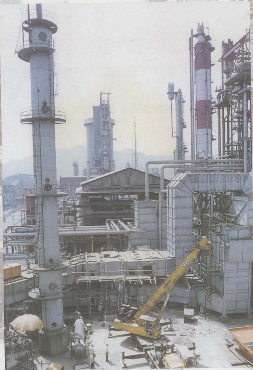
六项节能改造工程的主要项目——合成车间一段转化炉燃烧空气预热器改造正在施工
