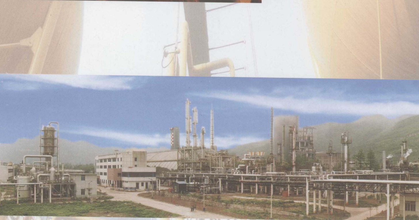
年产3万吨甲醇、6.6万吨甲醛、3万吨脲醛的生产装置
