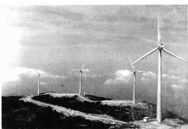
嵒苍山风电场是国内三大风电场之一，投资 2.14 亿元，装机 33 台，总装机容量 19.8 兆瓦，年发电量 4600 万千瓦时，于 1998 年 6 月 26 日正式并网发电。 王荣福 摄
