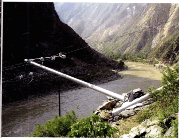
地震造成电力设施严重受损
