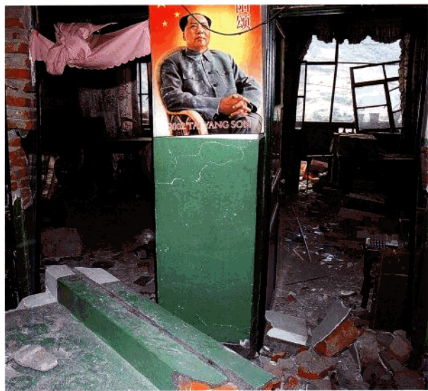
城市居民家被震毁的场景
