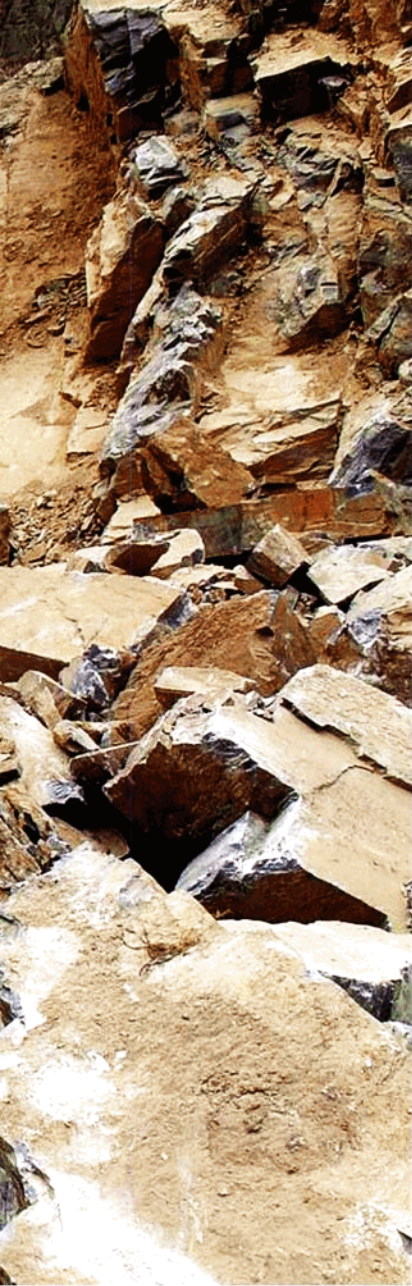
地震导致山体崩塌、滑坡，使公路严重受损，交通中断
