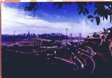
石板坡长江大桥立交
