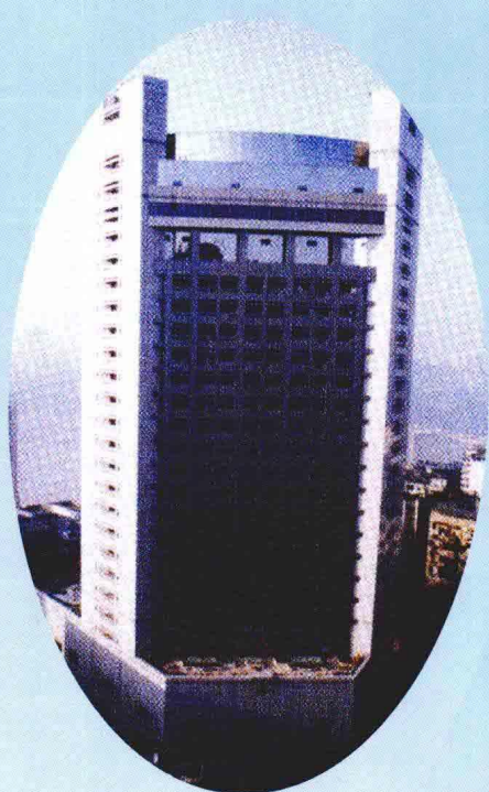
区政协2002年入驻管家巷9号区级机关综合大楼
