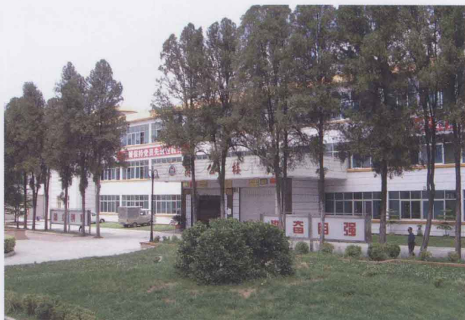
1979年修建的教学楼改造为办公楼
