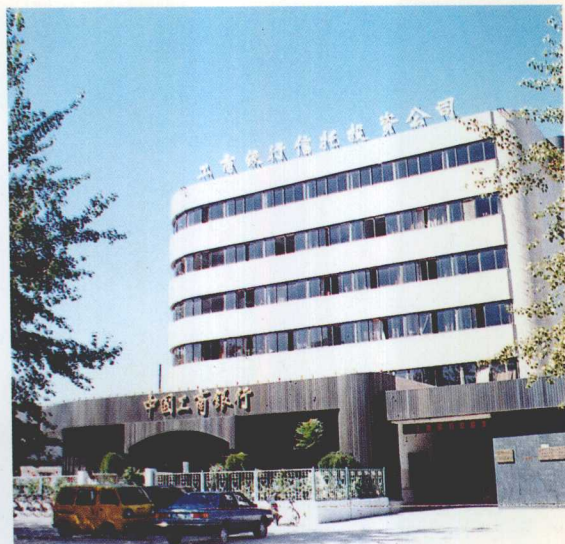
中国工商银行大楼
