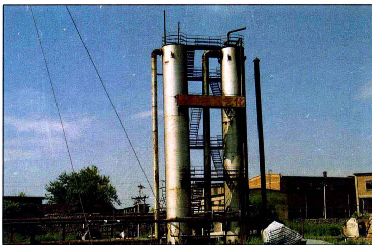
徐州新河二号井煤炭地下气化半工业性试验现场
