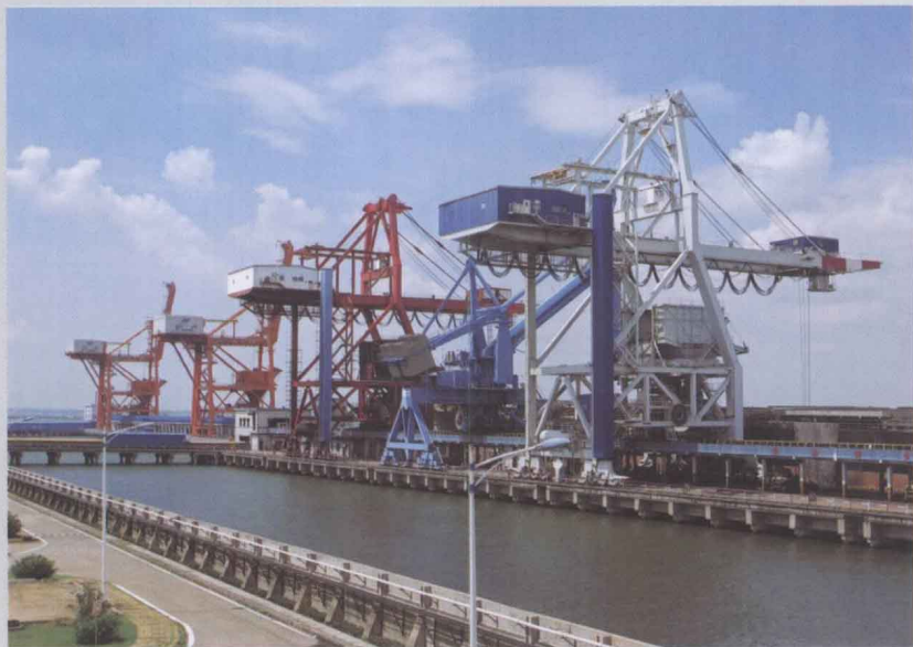
赤坎调顺岛电厂输煤码头（王志强 摄）
