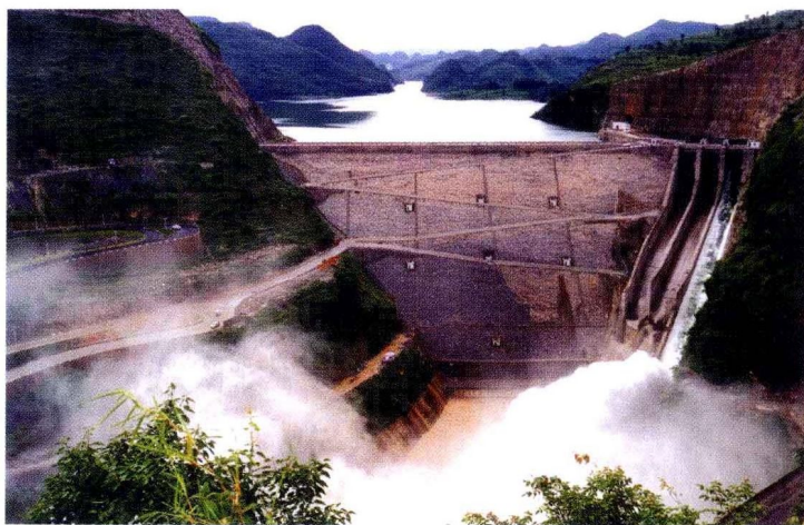
引子渡水电站泄洪
