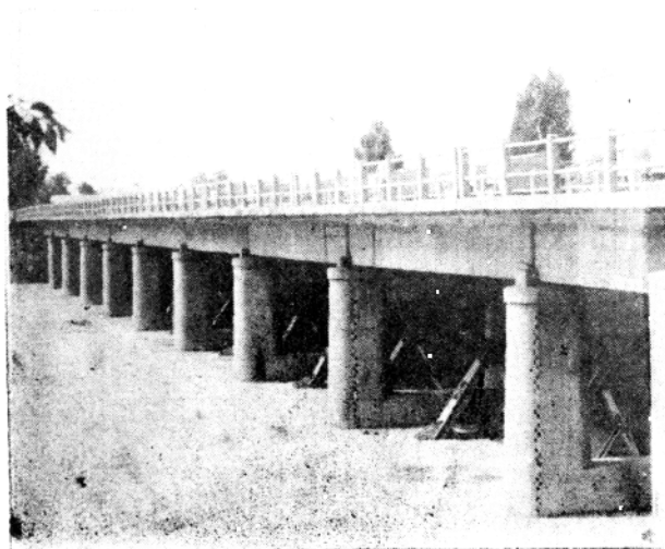
赵王新渠洩洪閘
