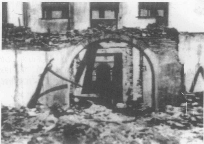
被炸后的武进医院门诊部
