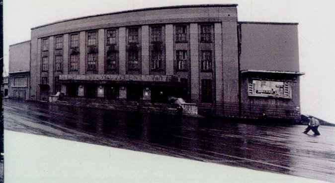
△ 学生承担本溪文化宫建筑工程金属构件的制作
