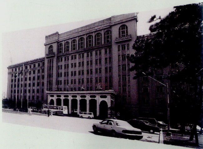
△ 学生承担辽宁大厦电气线路安装工程
