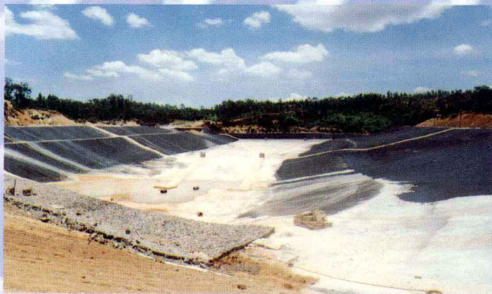
正在施工的湛江市生活垃圾处理场
