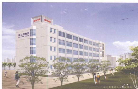
2007年将竣工的深圳新厂房
