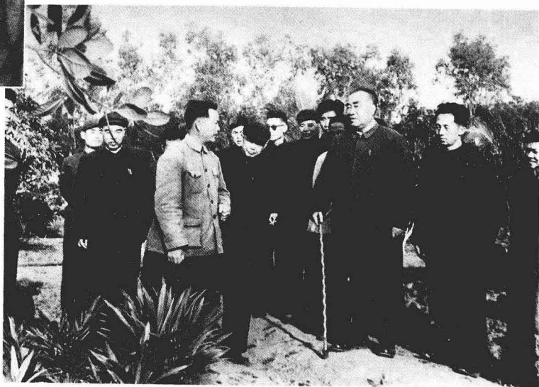
1963年1月，朱德同志到湛江视察工作。图为朱德同志在南亚热带作物研究所视察。
