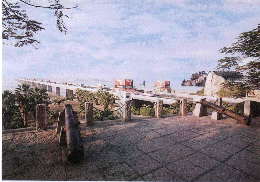
▲ 高崎寨东侧厦门大桥 刘成福摄
