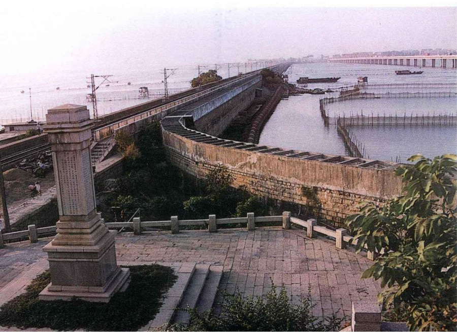
高崎寨西侧海堤 刘成福摄
