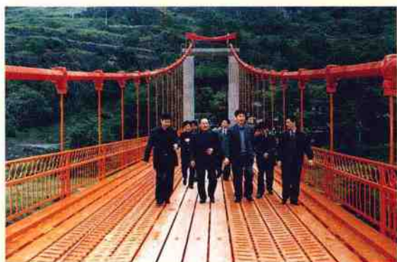
▲县领导检查经永雷两县修复的金沙江溪洛渡大桥 （夏延安 摄）
