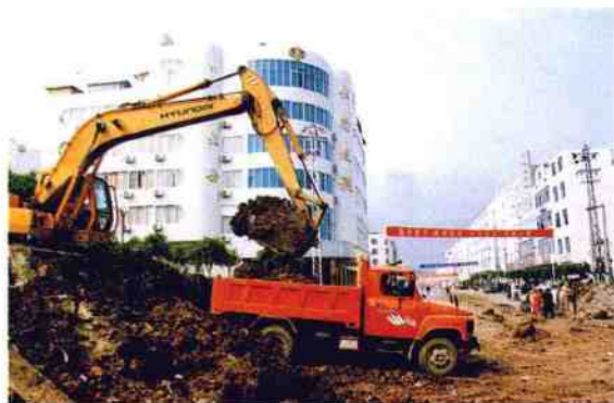
▲永善县振兴大街二期工程开工 (夏延安 摄)
