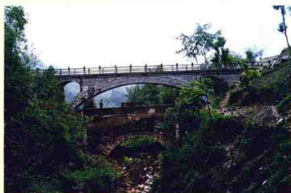
▲黄华龙冲河大桥竣工 (李文祥 摄)
