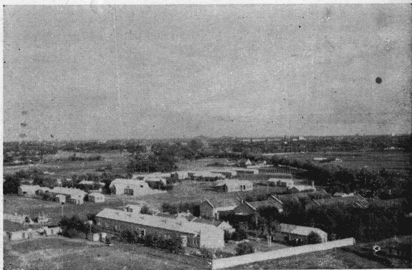
訓練部建築物全景（北京本場）
