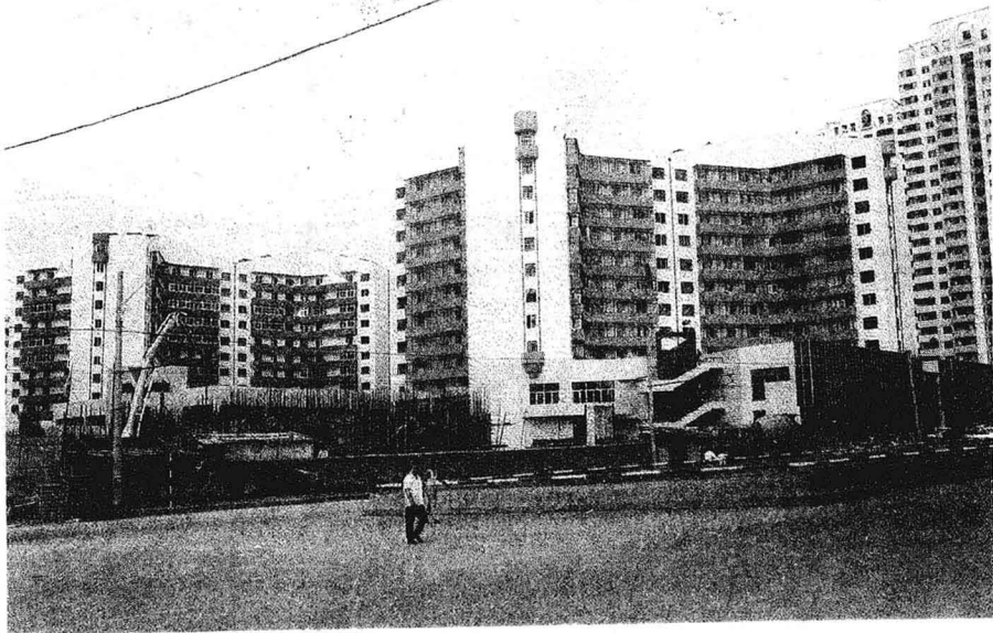
永丰改造区新住宅楼群
