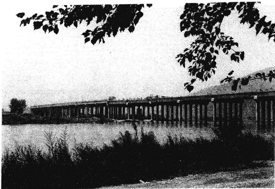
建设中的沈本高速公路
