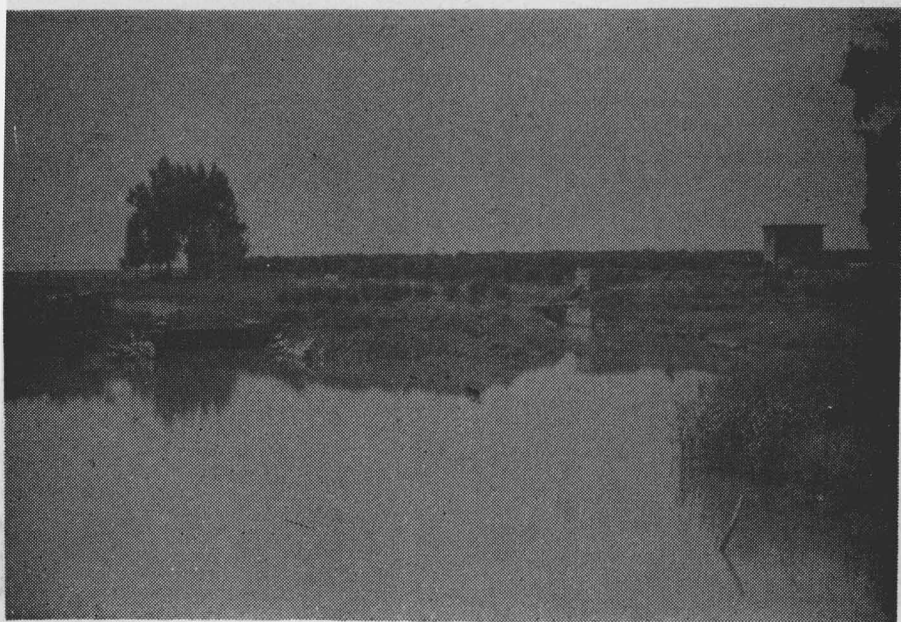
城門鄉浚邊水輪泵站全景
