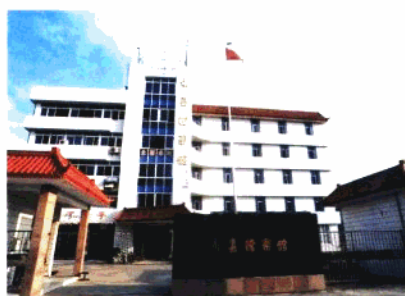
◀ 1997年2月9日，永嘉县档案馆竣工，主体工程建筑面积2424.27平方米，工程总投资410万元。
