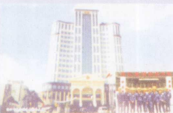
湛江地税局智能大厦综合系统工程
