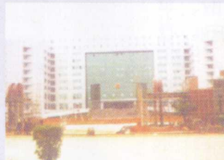
湛江麻章区政府综合布线工程
