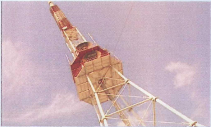
电视台发射塔
