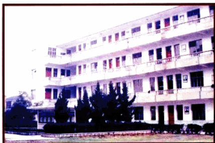
1985年建造的学校教学楼
