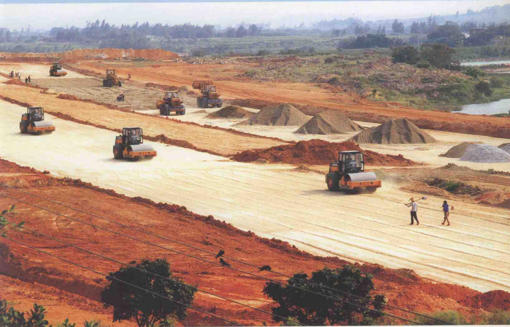
► 豪情拌热汗—翔安大道施工现场
