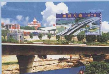
► 翔安大道一期工程
