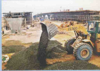
► 腾飞之路—建设中的全省最宽的翔安大道
