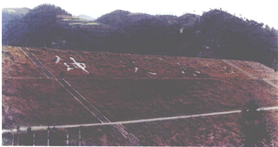
钟灵水库大坝
