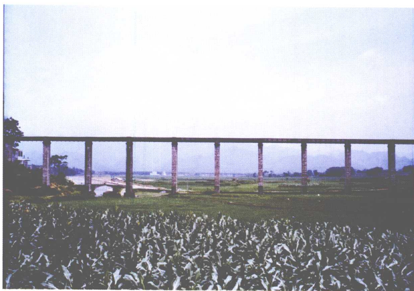
孝溪水库干渠四号渡槽
