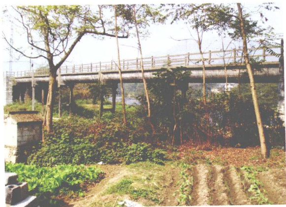
巨丰堰五拱桥渡槽
