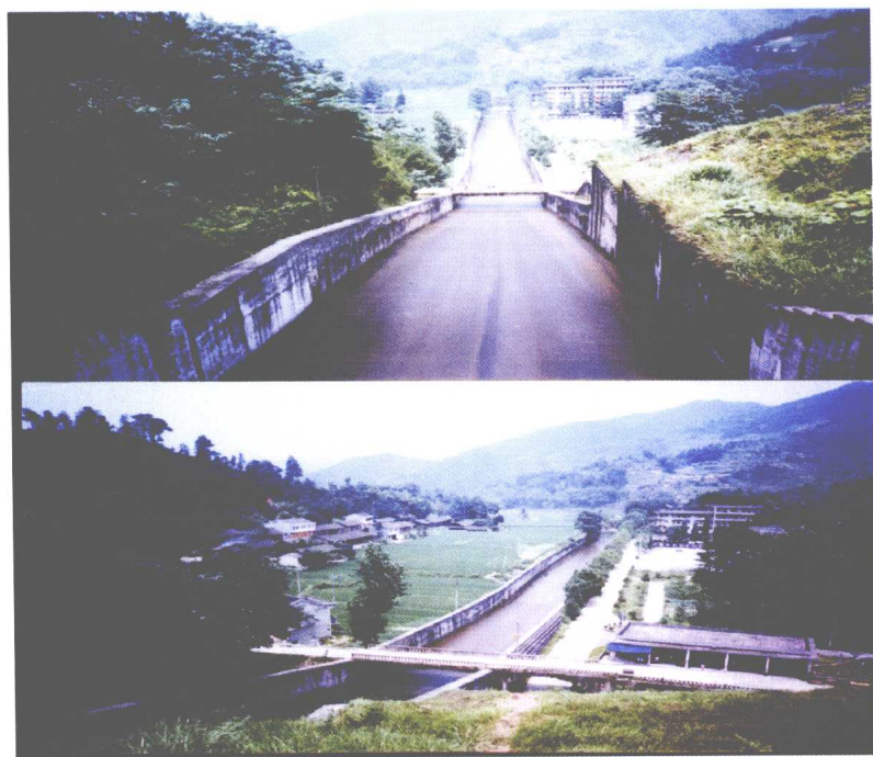
钟灵水库溢洪道
