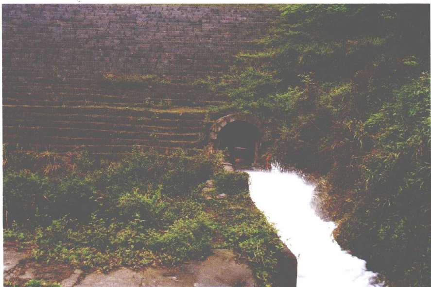
中和徐家水库放水隧洞
