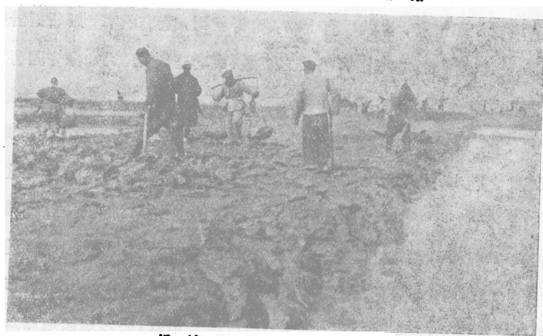
根 據 路 線 填 築 土 路
