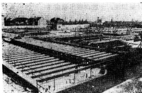
改造后的斜管沉淀池
