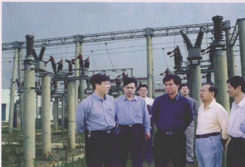
2003 年成立富川瑶族自治县水利电站有限公司。图为广西水利电业有限公司总经理陈润秋(中)在县委副书记罗良干、县水利电业有限公司总经理的陪同下视察电网建设情况。
