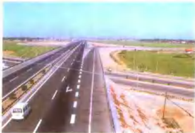
京深高速公路( 栾城出入口) 与 308 国道交汇处
