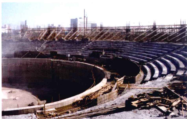
建设中的海洋剧院酷似一个球场。
