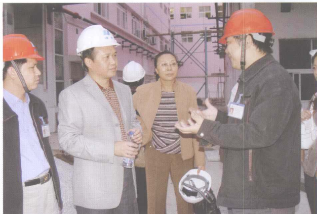
2005年10月，贵州省环保厅副厅长江平（左二）在遵视察电厂脱硫现场
