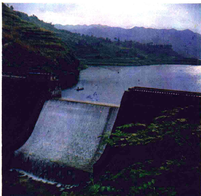
湄江水库大坝（图十一）
