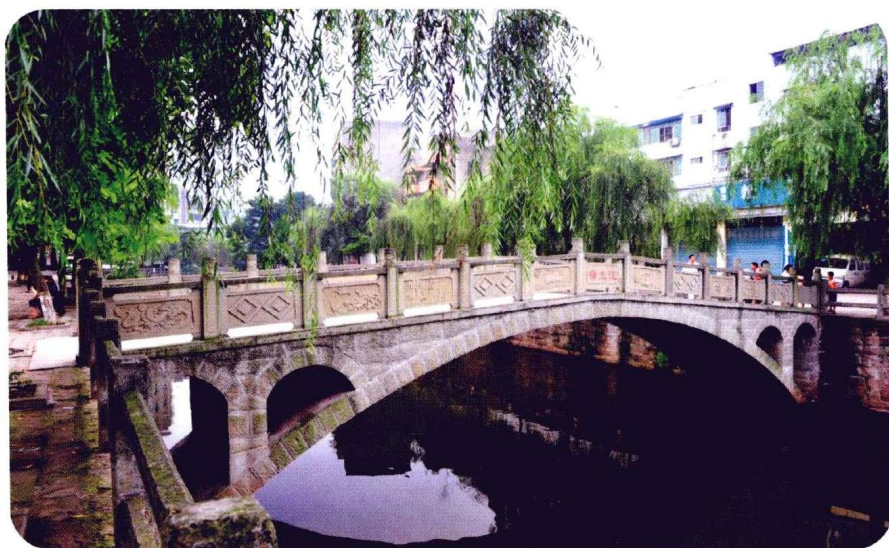
复生公园内的复生桥
