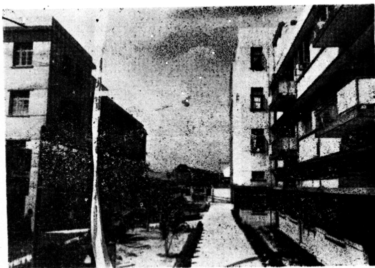
(二) 主体厂房一侧
