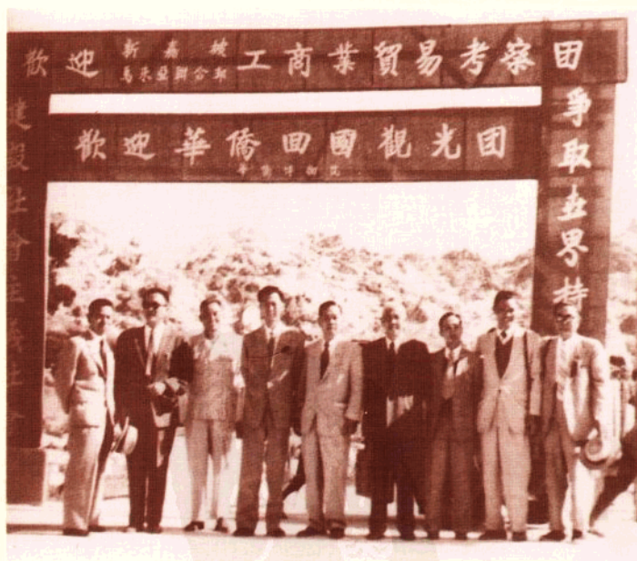
新加坡、馬來亞聯合 邦工商業貿易考察團 參觀本院基建工地
