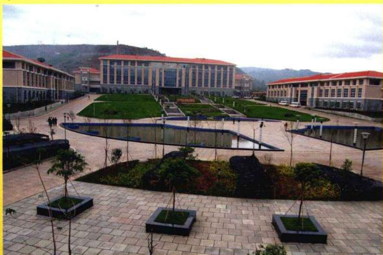
溪洛渡电站建设管理中心（位于永善县溪洛渡镇三坪）
