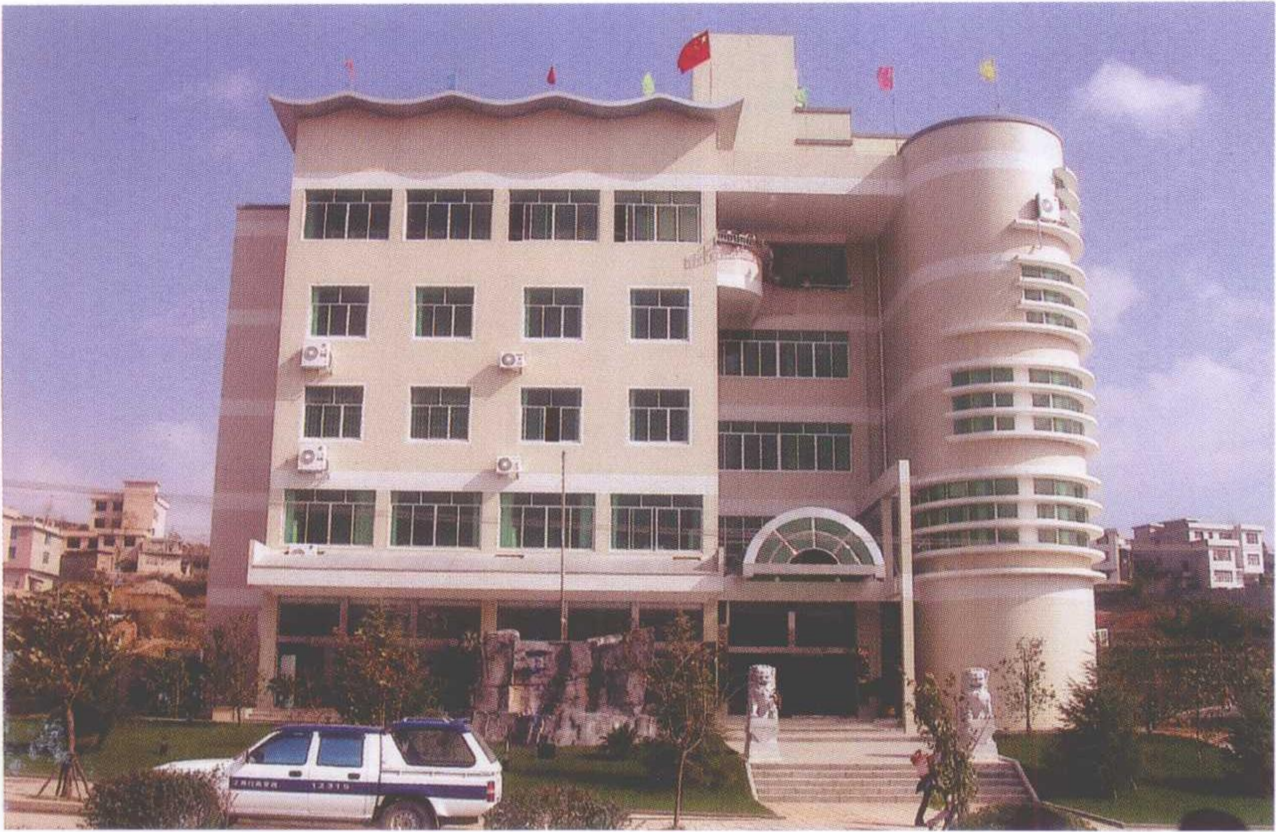
开阳县工商行政管理局办公楼
