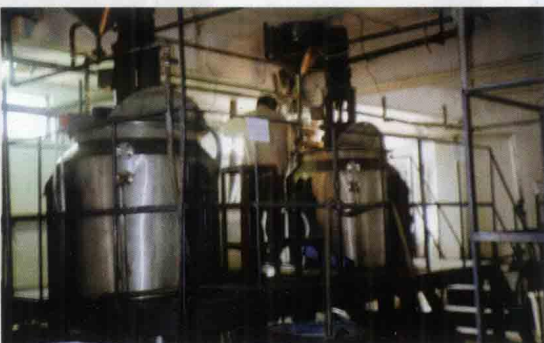
车间中现代水平的生产设备
