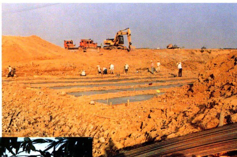
逕口電排站重建工程破土動工
