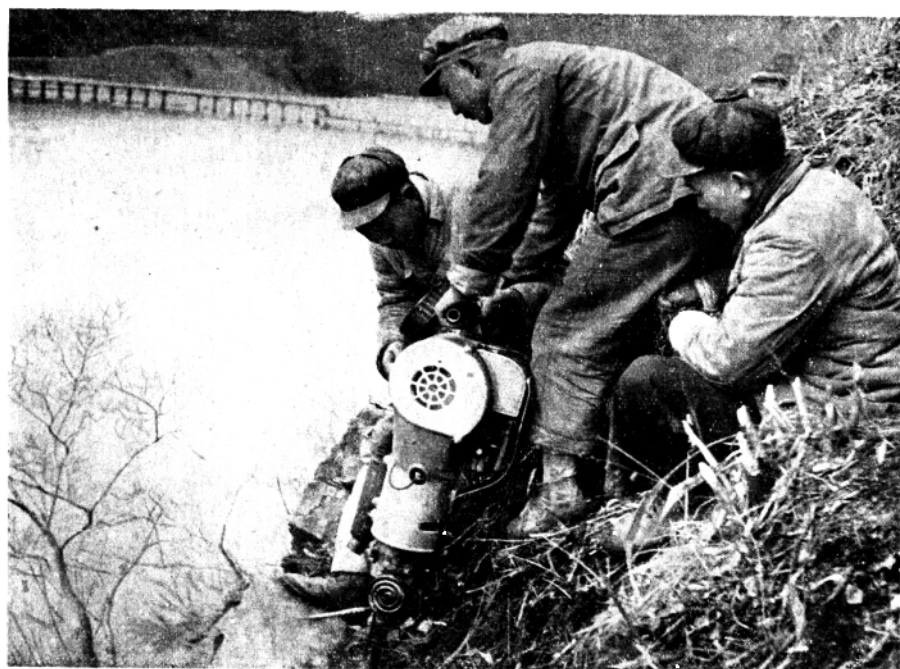
工人們用手提開山機開鑿趕運器材的佛六公路
