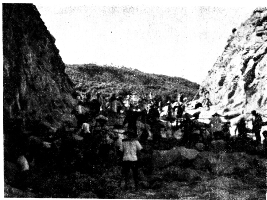
開挖溢洪道，民工們在清除爆炸的石方。
