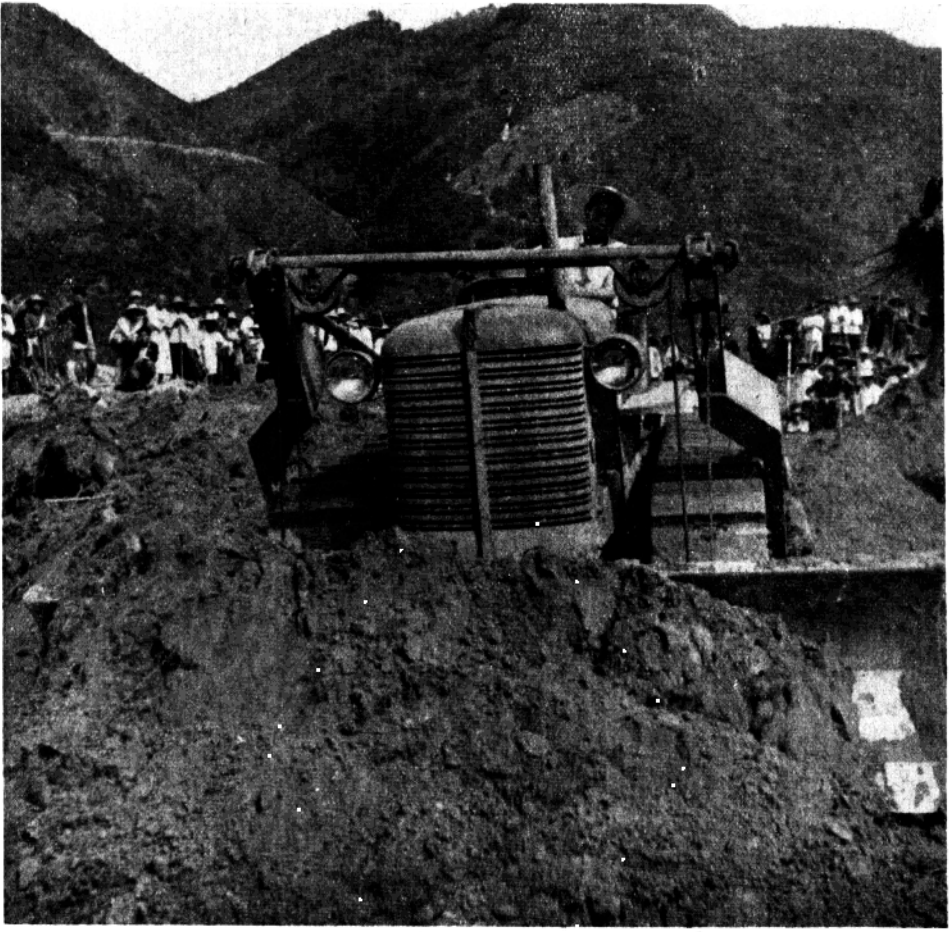
機械清基卸土處，使用推土機平土。
