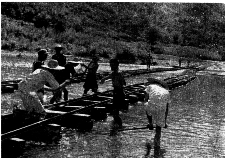
鐵道工人鋪築運送砂石材料的輕便鐵道
