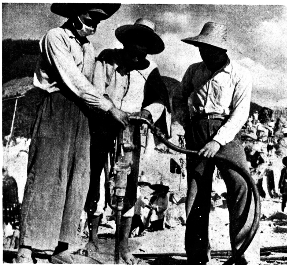
扶鑽工人用空氣鑽在清理好的岩層上鑽固結灌漿孔
