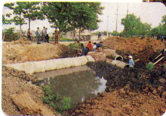
新拓宽的竹山路排水工程在施工
