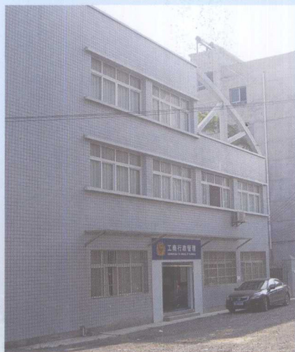
修葺一新的黄家坝分局办公大楼
