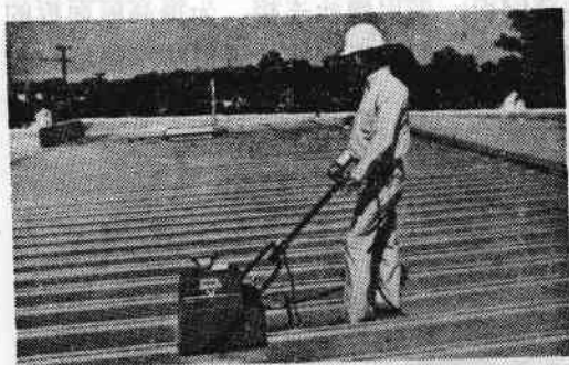
图32 屋面板采用机械连接
