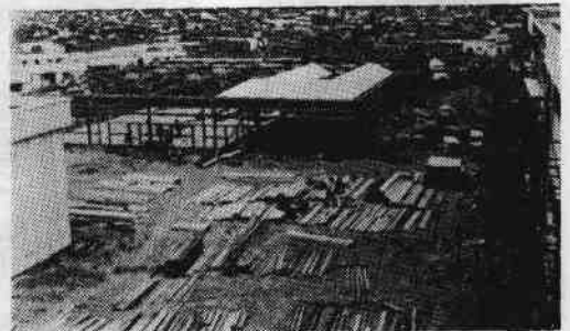
图18 西班牙钢框架挂板结构框架已组装好并开始铺设屋面板
