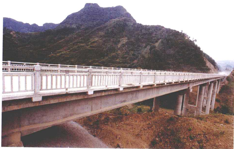
► 二〇〇三年建成的花地坪大桥
