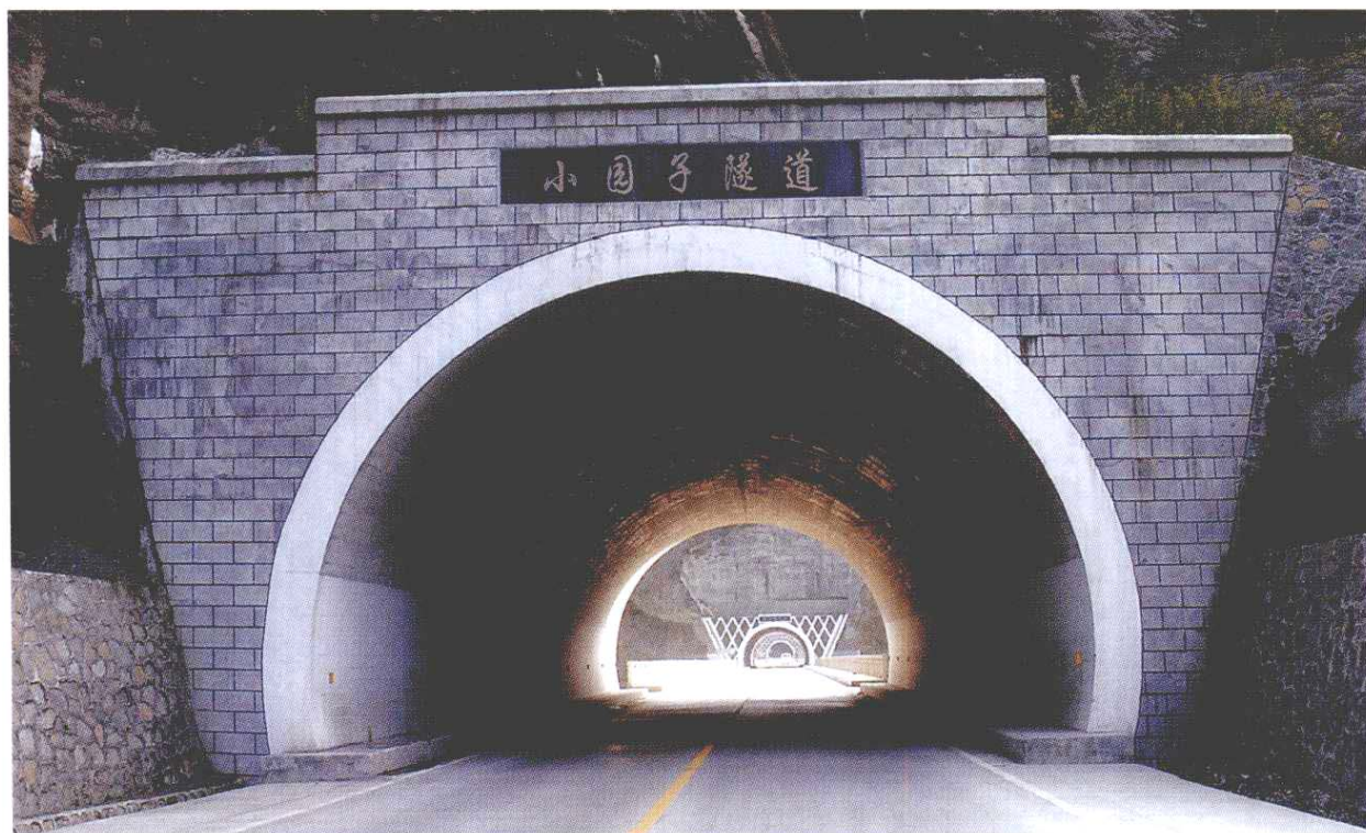
▲黔彭二级公路黔江段小园子隧道
