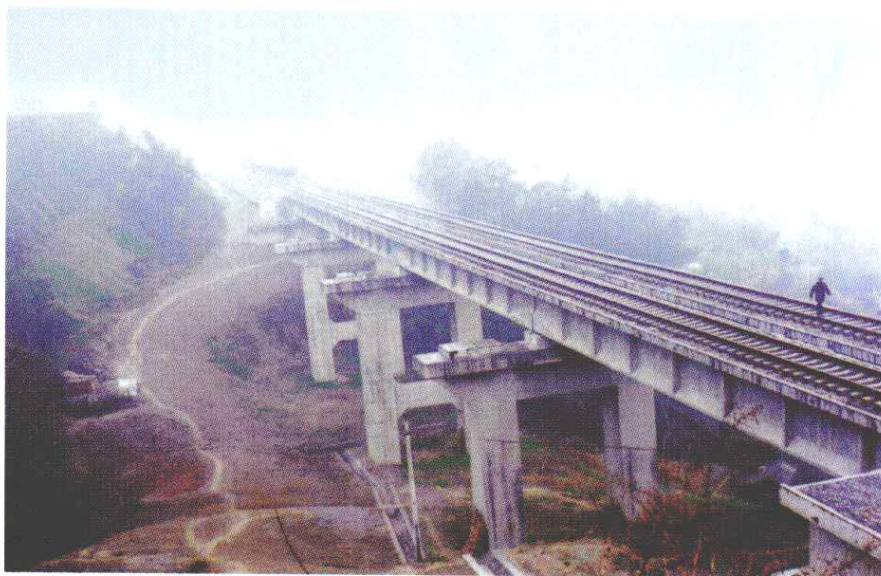
► 建设中的铁路大桥
