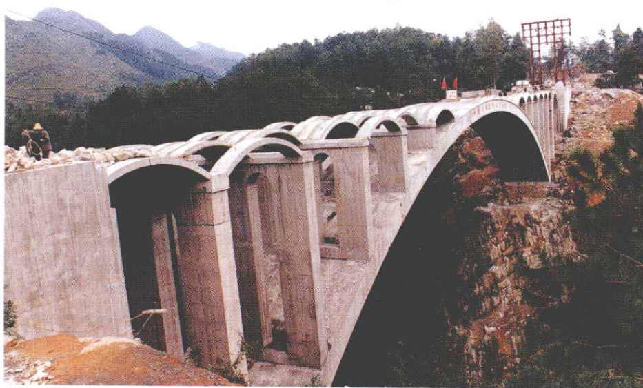
◀ 二〇〇五年动工兴建中的正 舟大桥
