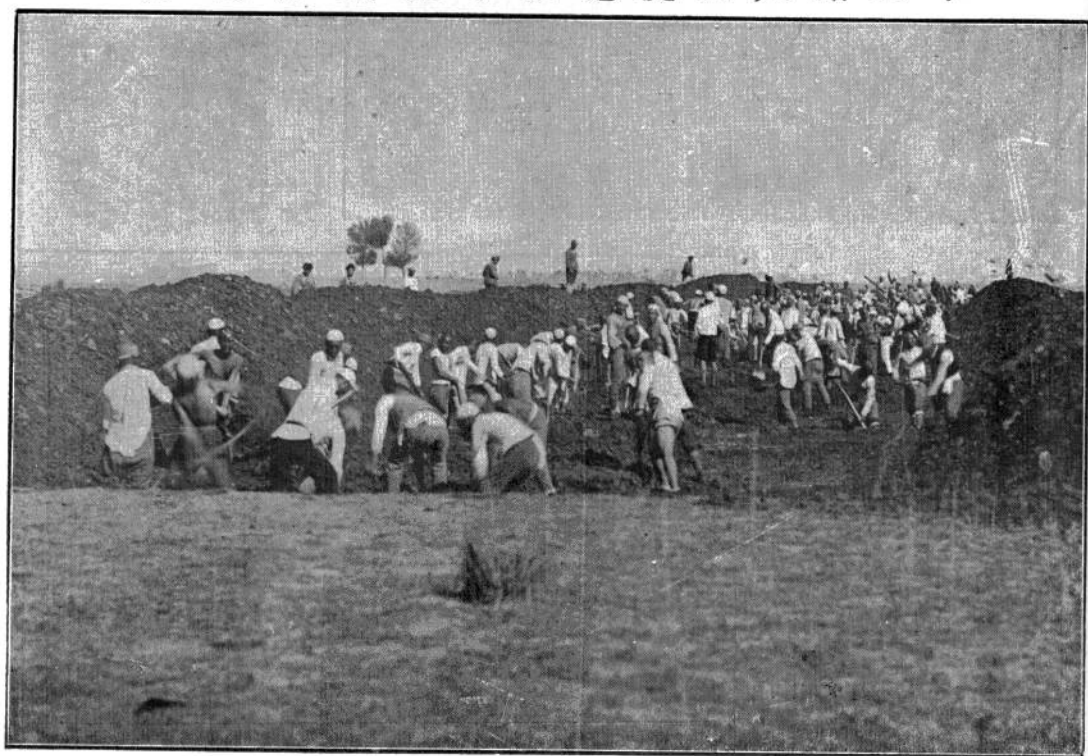
五十路兵工挑挖雲亭渠工作情形
