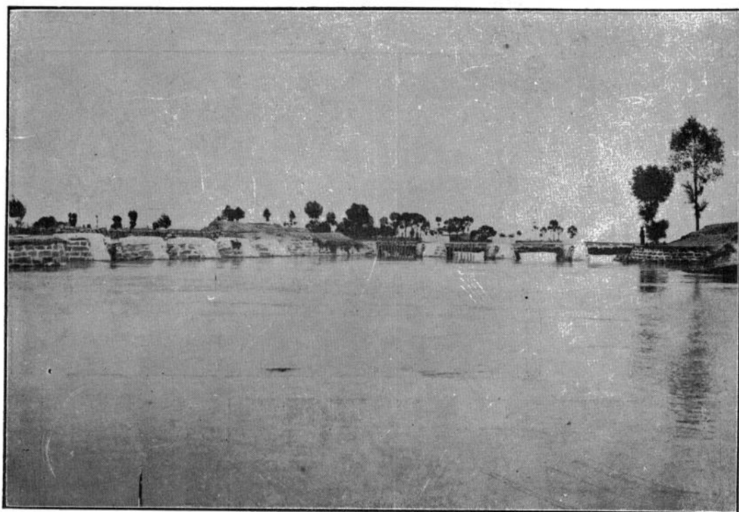
惠農渠龍門橋之正閘
